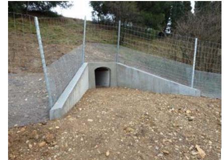
Photo de l'ouvrage achevé
