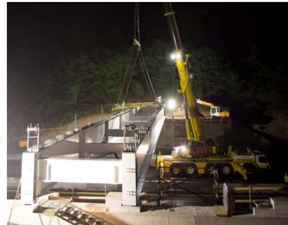
Installation de la charpente de l'éco-pont en mai 2011
